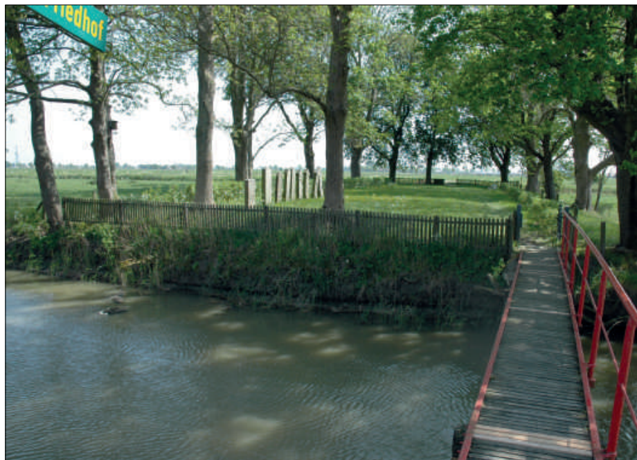
Über 50 Jahre diente eine einfache Fußgängerbrücke als Übergang zum jüdischen Friedhof in Jemgum. Im Herbst 2017 ließ der Bürgermeister die sanierungsbedürftige Brücke abreißen.
