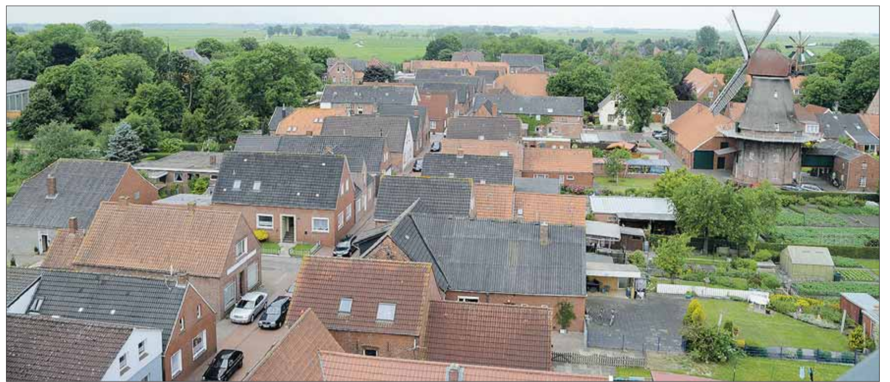
Der Ortskern von Jemgum: Dichtbesiedelt - und mit entsprechenden Konfliktbereichen. Hier könnte der Rahmenplan auch ansetzen.
