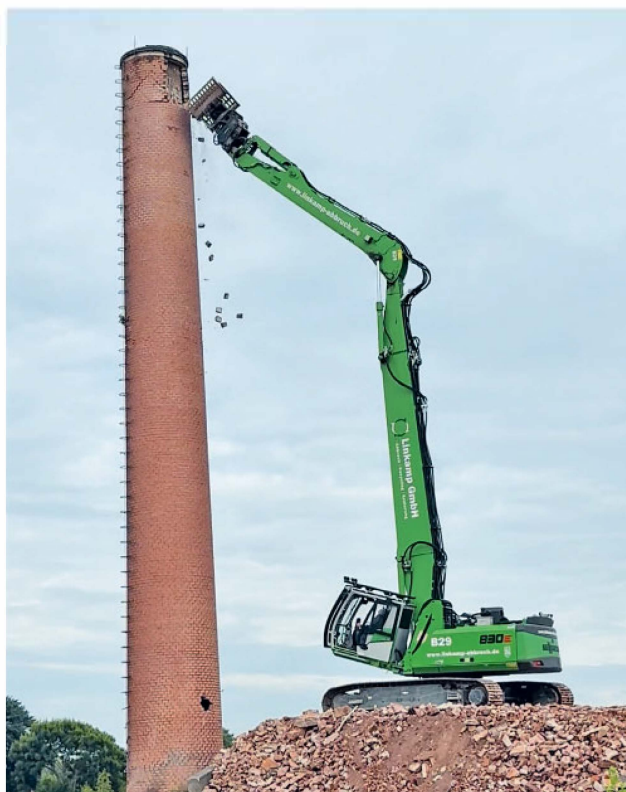
Der Schornstein ist gefallen, letzter Akt im Abriss der alten Ziegelei. Wird hier bezahlbarer Wohnraum entstehen? (Foto: Sarah Hensmann)
