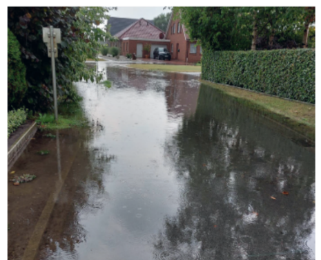
Nach Starkregen: überschwemmte Lieder Straße.
